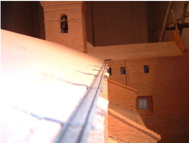
Le grondaie applicate al tetto prima dei coppi
