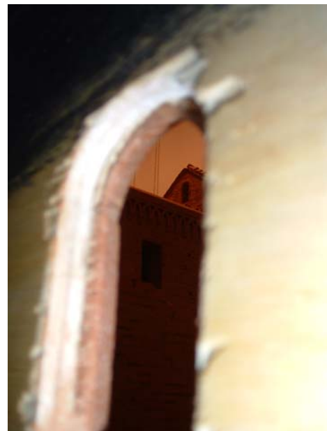
“Scarico” sulla parete interna per montare il vetro
