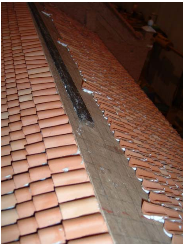
I coppi durante il montaggio, vedi situazione a dx e sx
