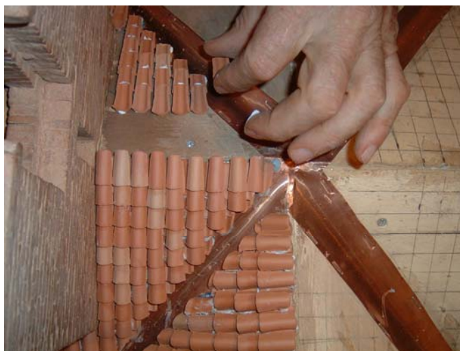
Montaggio delle tegole sulle converse
