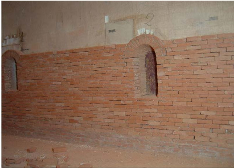
Il muro sale intorno alle finestre
