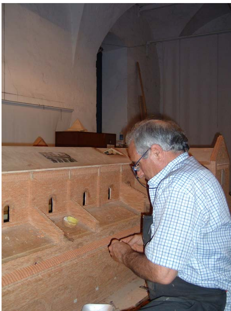
Gianni Lupini sta realizzando l'accenno di tetto del chiostro sulla navata laterale
